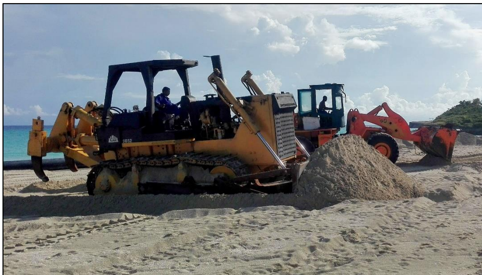
Foto 21: Nivelado y conformación del perfil de playa por medios mecánicos.
