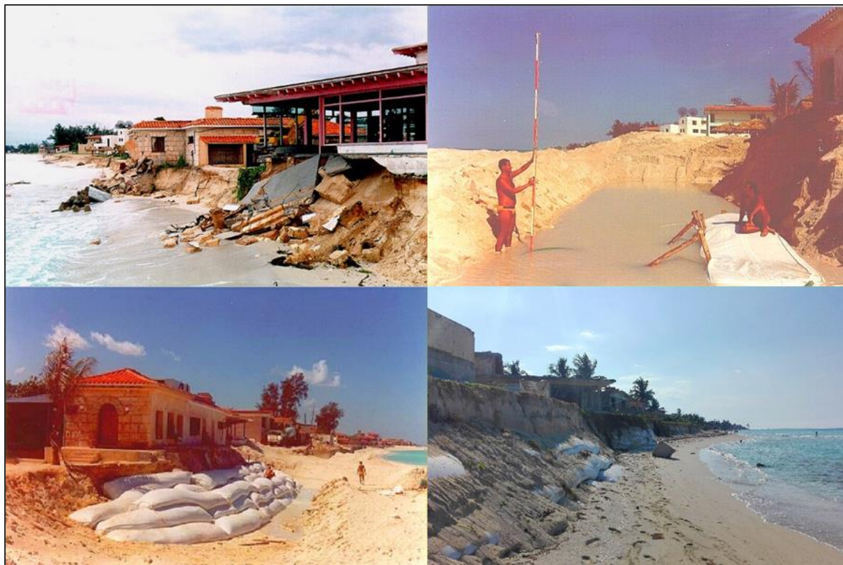
Fotograma 4: Cuatro momentos de la protección de construcciones ocupantes de la duna en el extremo occidental de la playa de Varadero, Cuba: Destrucción previa; inicio y final de la ejecución del proyecto; y exposición de las estructuras en excelente estado de conservación tras más de 15 años, y cumpliendo aún su función de preservación de los cimientos de las construcciones a su resguardo.
