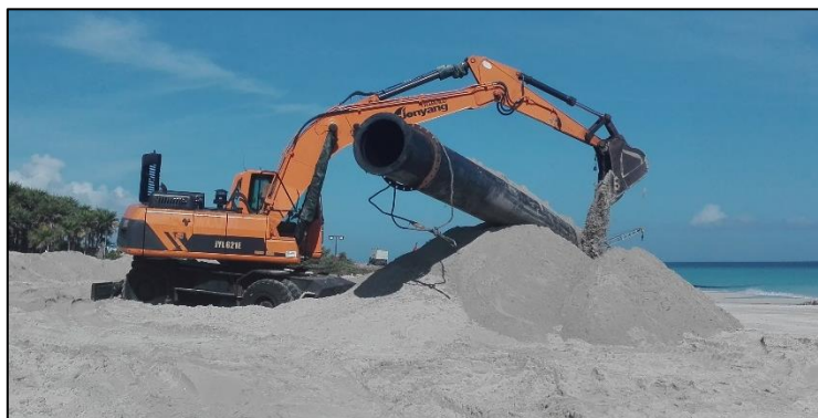
Foto 19: Retroexcavadora colocando el extremo de la tubería en el punto de vertido.
